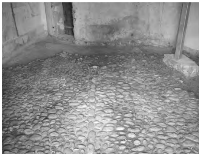
Die Katzenkopf-Pflästerung aus der Zeit um 1725 vor dem mittelalterlichen Rundturm.
